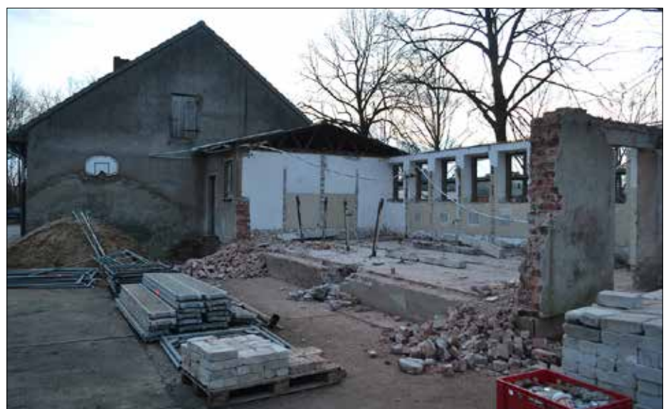
Der ehemalige Toilettentrakt an der alten Schule in Rastow
