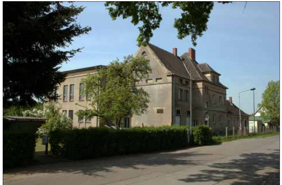
Das Rastower Schalthaus in der Goldenstädter Straße Foto, Peter Möller
